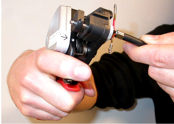
Bild 6.81: Zuschneiden eines LWL (3)
